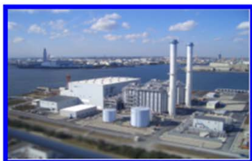
東京ガス扇島 81万kW
